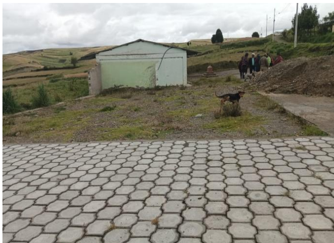
ADOQUÍN COLOCADO
