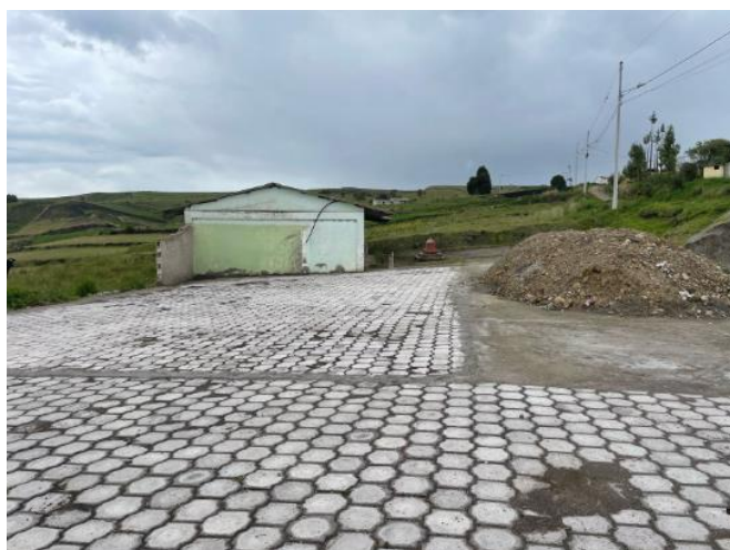
ADOQUÍN COLOCADO
